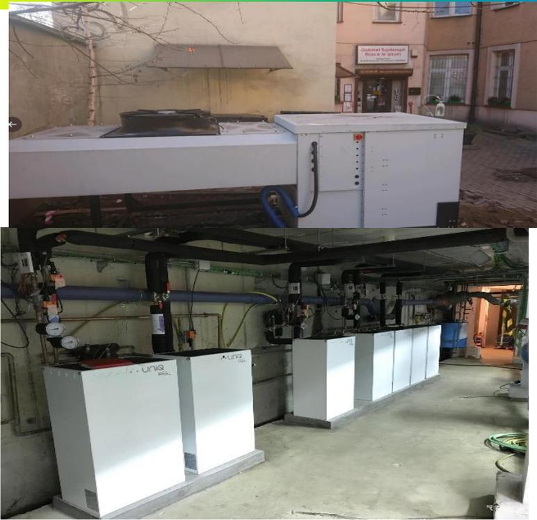
在欧盟H2020基金委Heat4Cool项目中，Sunamp Heat Batteries可储存由太阳能PV板直接驱动热泵的能量，并用于空间加热/冷却以及提供热水。
